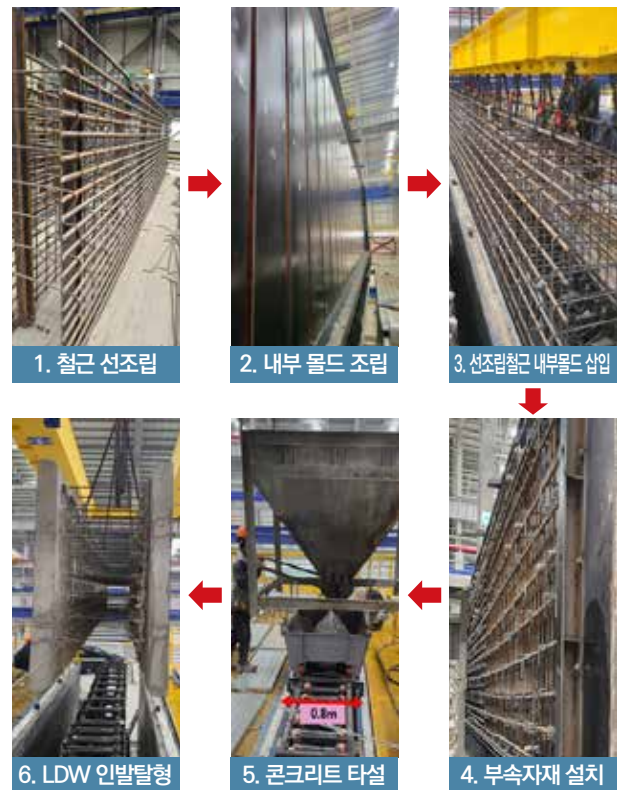
사진 1. LDW 제작 모습
