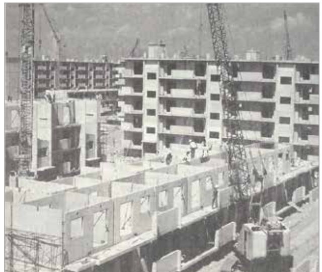
그림 11f. 철산 PC 광복아파트 공사 전경(출처: 한성 10년사, p.33-35)
