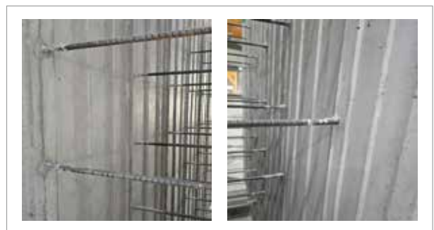
사진 5. 전단기(shear key) 및 전단철근 배치모습
