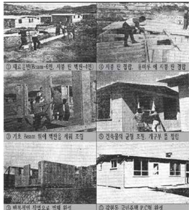
그림 5. 갈현동 PC 국민주택 건설과정(출처: 우규택, 2016 p.34)
