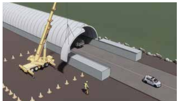
그림 4. PC 제작 및 설치
