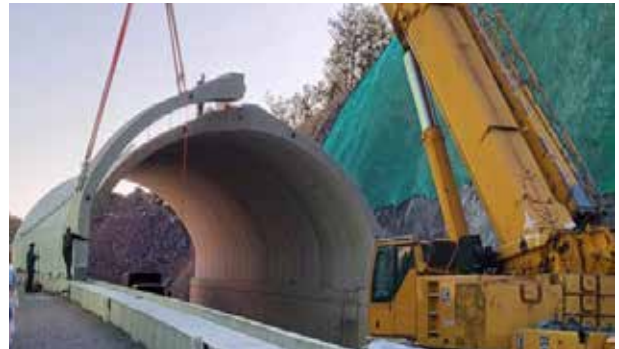
그림 4. PC 제작 및 설치
